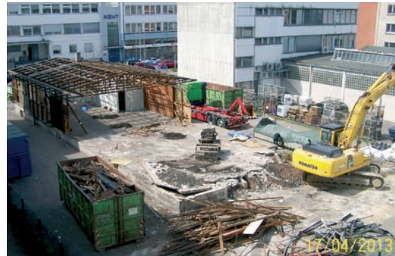
Kein Abriss ohne exakte Trennung der Baustoffe. No demolition without precise separation of construction materials.
